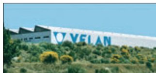
Lisbon, Portugal Velan Válvulas Industriais, Lda.
