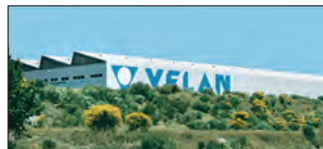
Lisbon, Portugal Velan Válvulas Industriais, Lda.
